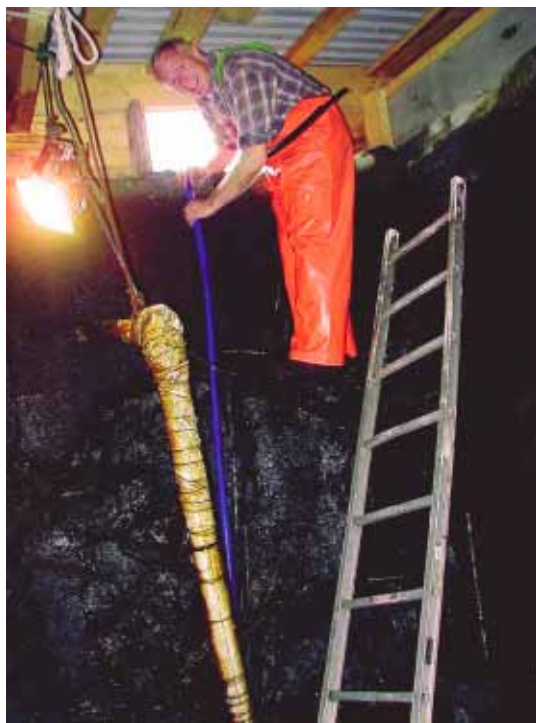
Oppsynsmann på Hitsøy og Løno, Steinar Lønøy i arbeid med rensing av brønn på Hitsøy
